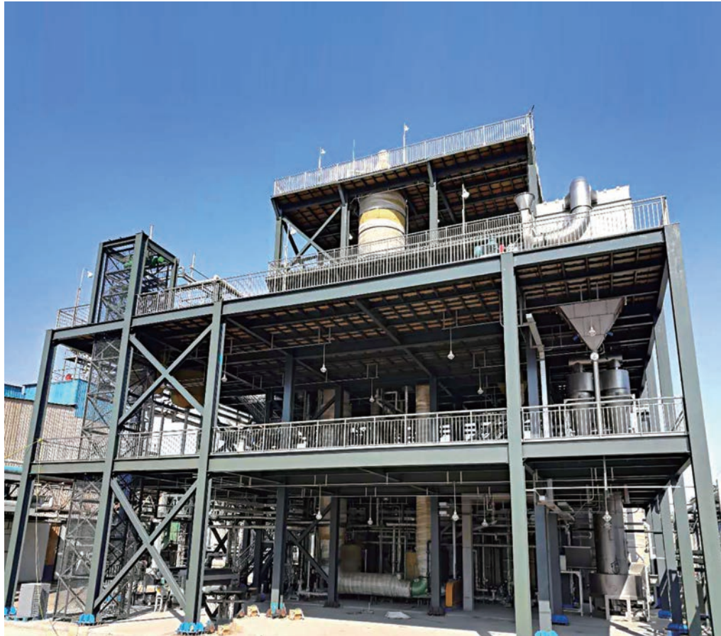
▲ 硫酸钠废水蒸发结晶系统
